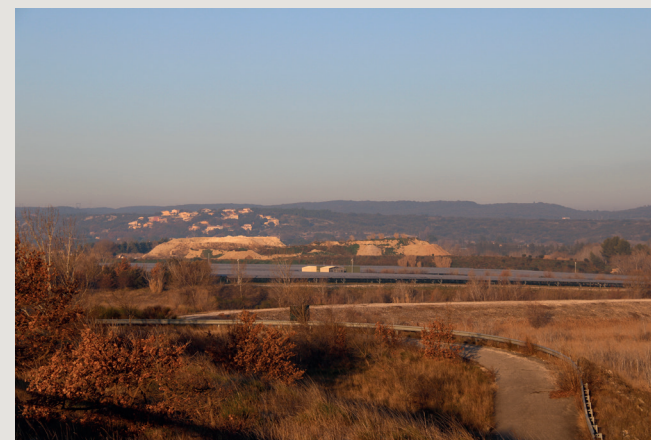
Le parc photovoltaïque de Pujaut, dans la zone industrielle aux abords de la Ligne à Grande Vitesse, une friche ferroviaire anciennement décharge pour matériaux de construction.
