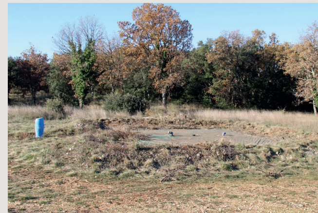
▲ Citerne enterrée très peu perceptible
