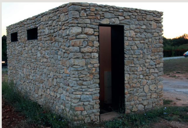
▲ Poste en bardage pierre
