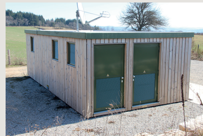
▲ Poste en bardage bois
