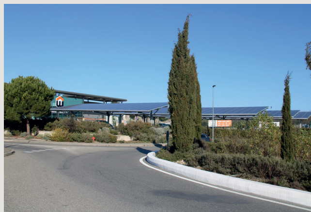
▲ Les ombrières photovoltaïques sur le parking d'une zone commerciale aux Angles.
