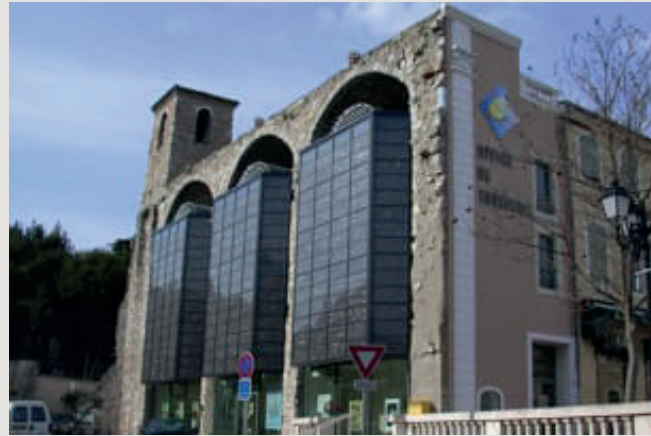
▲ Exemple d'usage de panneaux photovoltaïques jouant un rôle dans le projet architectural. L'aspect technique est dépassé et le panneau photovoltaïque devient une composante à part entière de l'architecture. Office de Tourisme de d'Alès.
