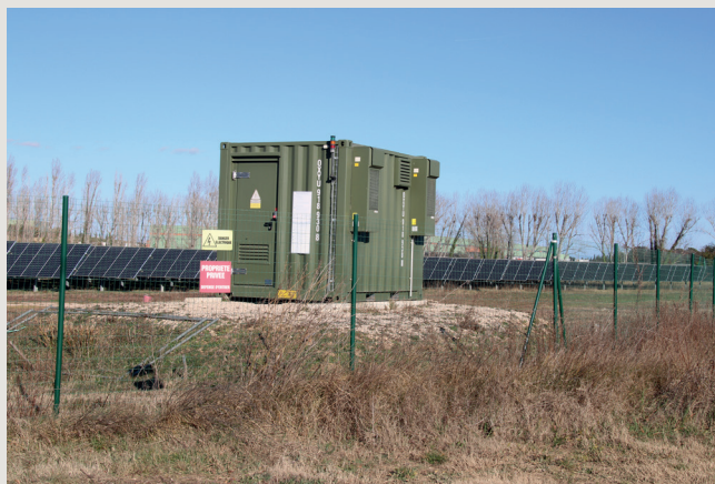
▲ Les fondations doivent être soignées sans terrassement d'importance.
