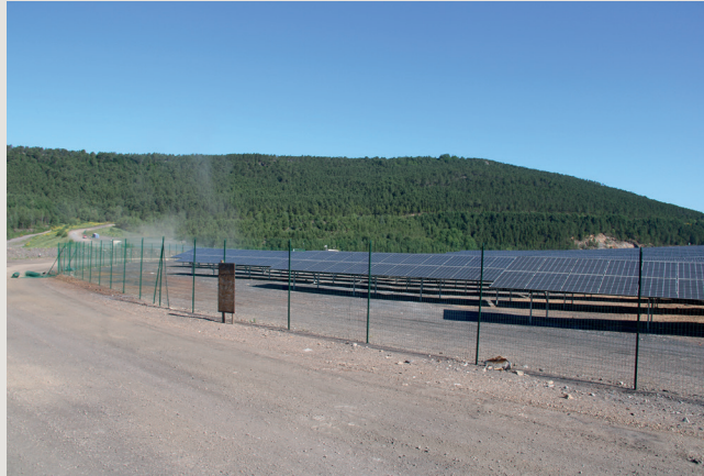
▲ Le parc photovoltaïque sur l'ancienne mine de charbon du Grand Baume à la Grand-Combe. Le positionnement des panneaux dans une zone de faible altimétrie permet de conserver les vues sur les massifs boisés depuis les points de vue environnants.
