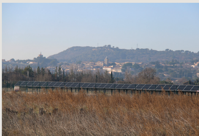
▲ Le parc photovoltaïque de Sernhac à proximité de l'autoroute A9, par son site d'implantation en zone agricole et sa situation, le parc photovoltaïque est en covisibilité avec la silhouette villageoise de Sernhac. L'observateur riverain garde tout de même ses repères essentiels et habituels dans le paysage, comme le village et le coteau en arrière-plan.
