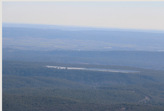
Depuis le mont Bouquet, l'étendue du parc photovoltaïque d'Aigaliers (24 ha) s'impose dans la garrigue. La lecture du parc est renforcée par sa forme géométrique et des types de panneaux différents au sein du même ensemble.
