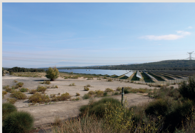
Le parc photovoltaïque de Rochefort-du-Gard, à 100 mètres de l'autoroute A9, prend place sur un délaissé routier. Le parc n'est pas visible depuis le village. Un sentier sur les énergies renouvelables relie le parc au village. Un projet d'extension est actuellement en cours.
