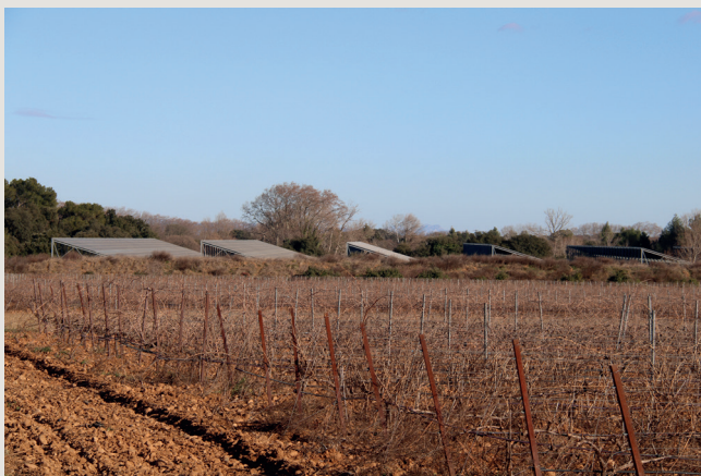
▲ Les panneaux photovoltaïques sur arboriculture à Bellegarde en zone agricole.
