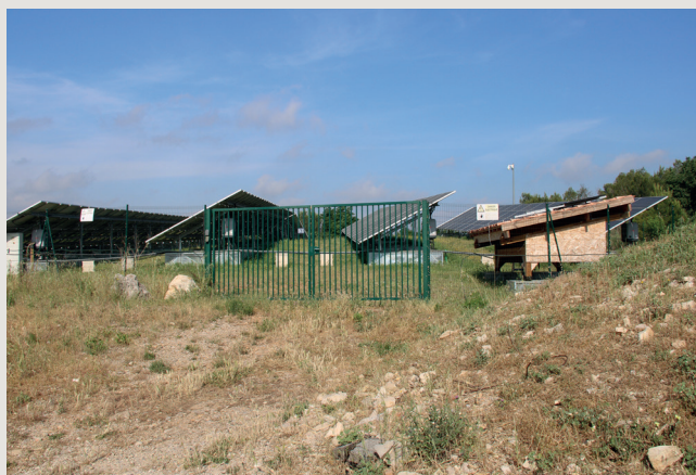
▲ Des abords de parc à réhabiliter
