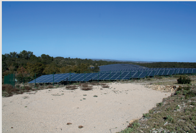
▲ L'ambiance paysagère à dominante minérale des chemins et plateformes. Les délaissés sont à évacuer après travaux pour retrouver une morphologie et l'occupation du sol initiale du site.
