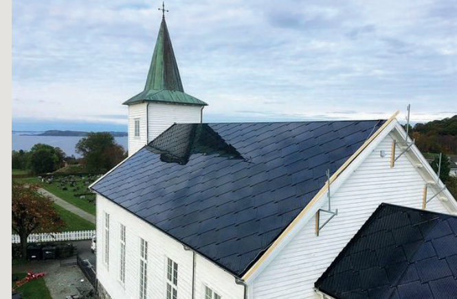
▲ Exemple d'intégration ingénieuse de panneaux photovoltaïques sur toiture. Le design des panneaux et la pose sont effectués avec sobriété (absence de bordures métalliques grises ou peintes en noir, couverture complète de la toiture sans rebord inesthétique).
