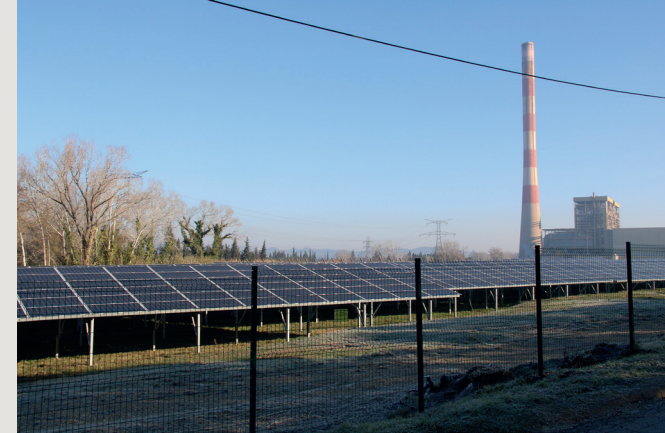
▲ Le parc photovoltaïque d'Aramon, au pied de l'ancienne centrale thermique et sa grande cheminée. La zone d'activités contient de nombreux objets de différentes échelles. Les formes géométriques des parcs photovoltaïques proposent une unité ordonnée.
