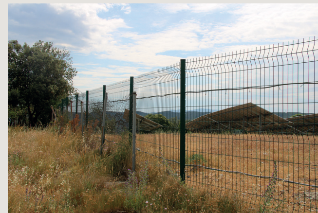
▲ Ici, la clôture est venue se superposer à une clôture existante, créant une confusion.
