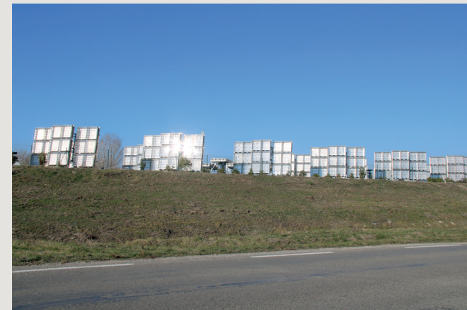
▲ Le parc photovoltaïque de Vallabrègues avec la technologie du photovoltaïque à concentration, très perceptible dans le paysage.
